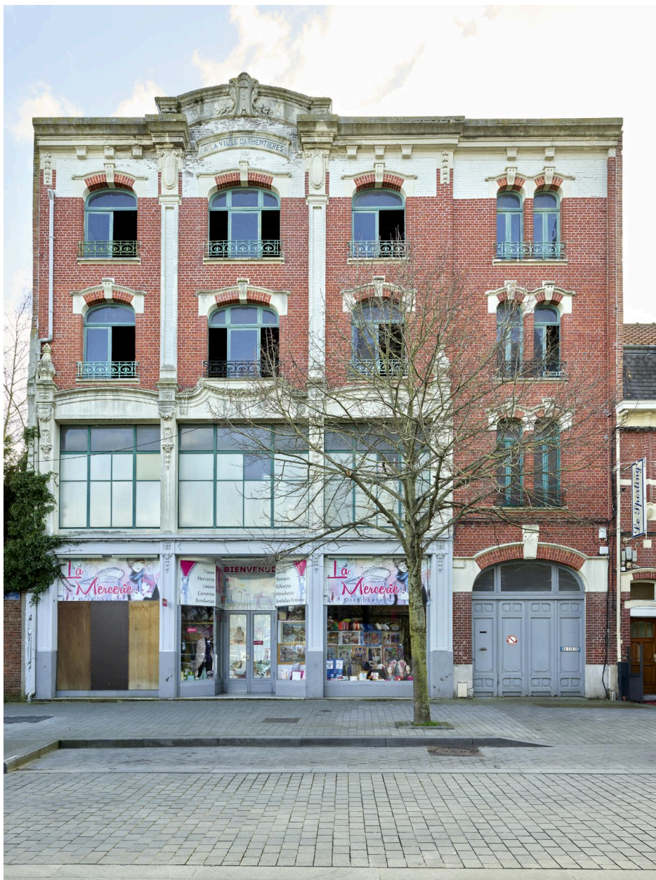
Élévation antérieure en 2023.
