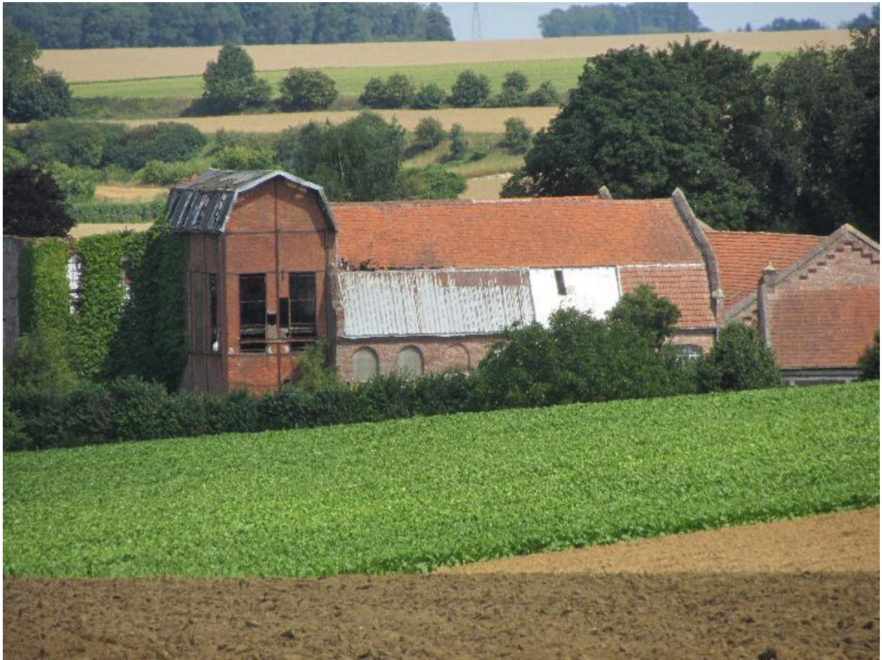
Vue d'ensemble sud.
