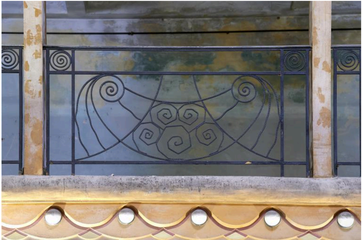
Détail du garde-corps en ferronnerie du premier étage autour du grand atrium principal.
