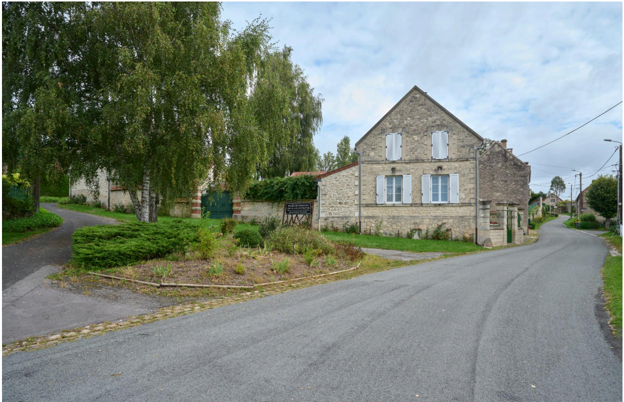
Maison et sa cour, vue ouest sur le carrefour.
