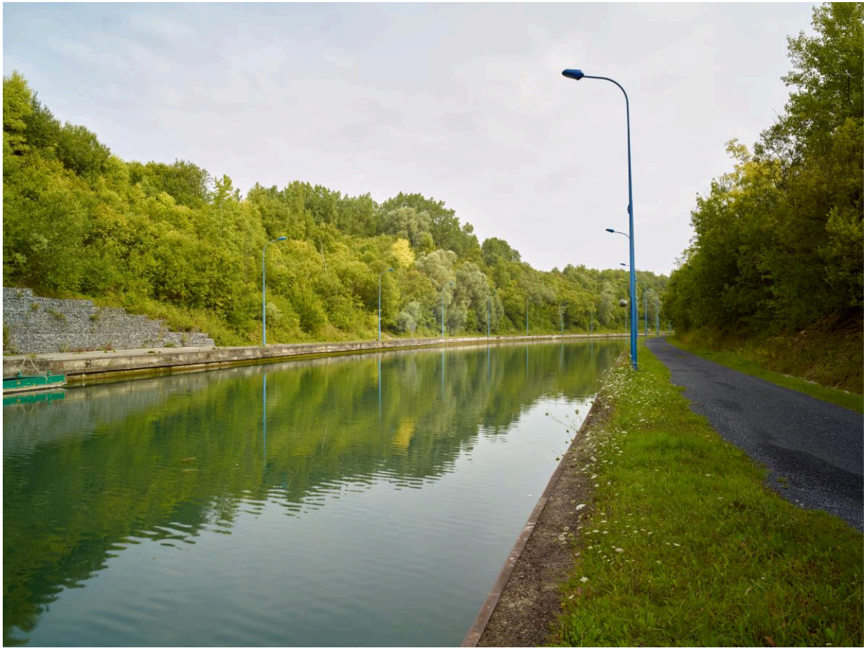
Vue depuis la tête nord vers le canal et le quai de stationnement des péniches.
