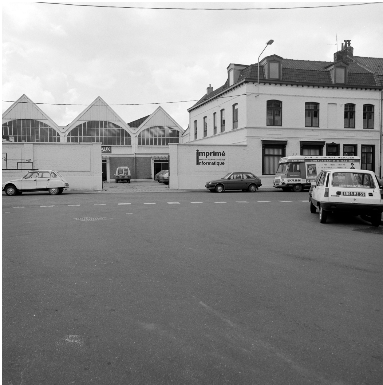
Vue générale vers l'ouest, prise depuis la rue.
