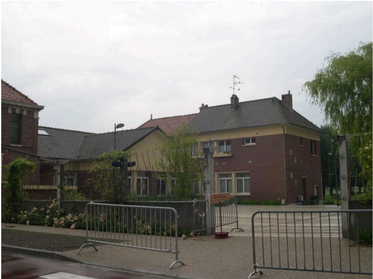
Détail sur l'extension nord-est.
