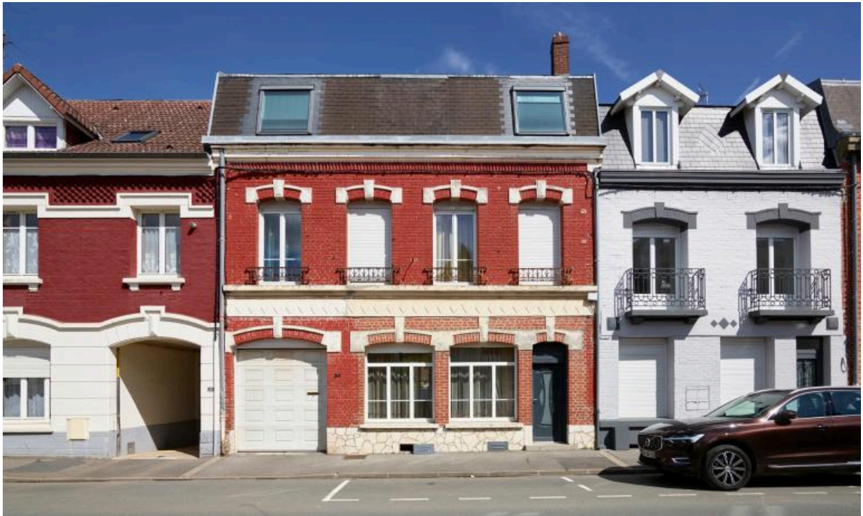
Maison, n° 30 rue du faubourg de Péronne. Vue de la façade principale. Exemple de maison avec distribution latérale et deux baies géminées en rez-de-chaussée.
