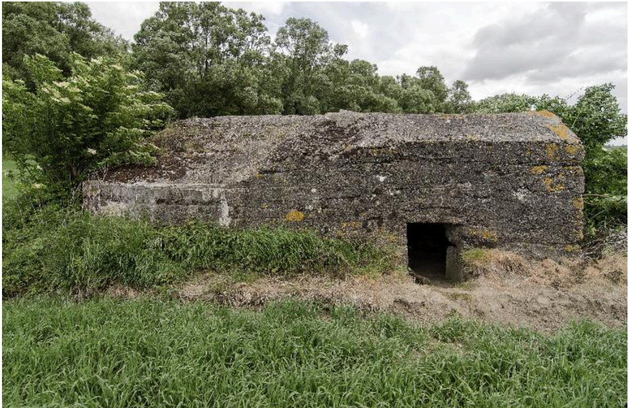
Vue latérale vers le nord-est. Entrée
