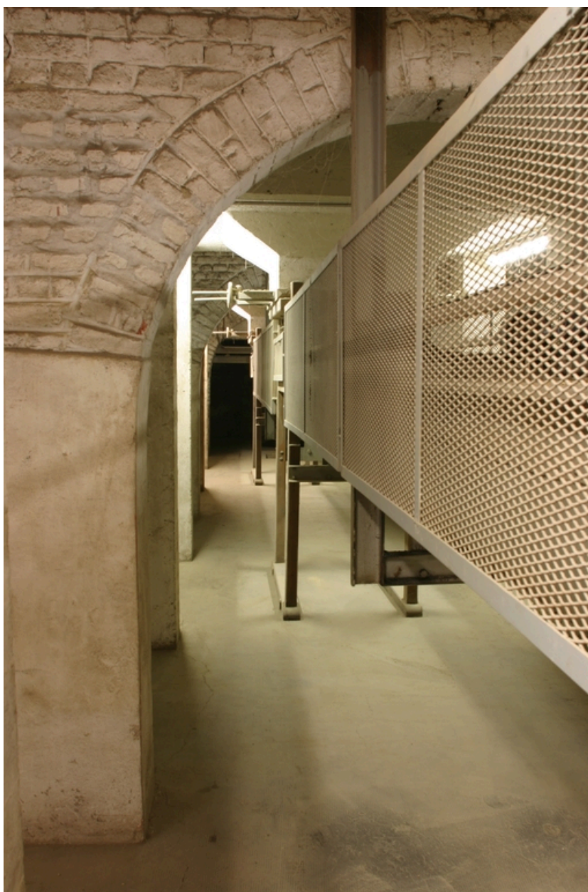
Base des cellules du silo à blé.
