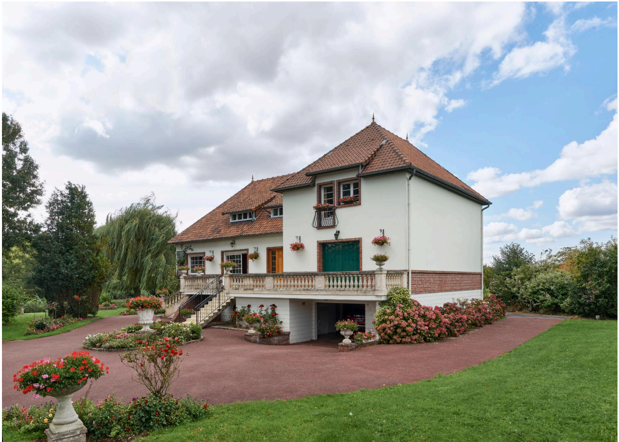
Maison, vue prise depuis le nord-est.
