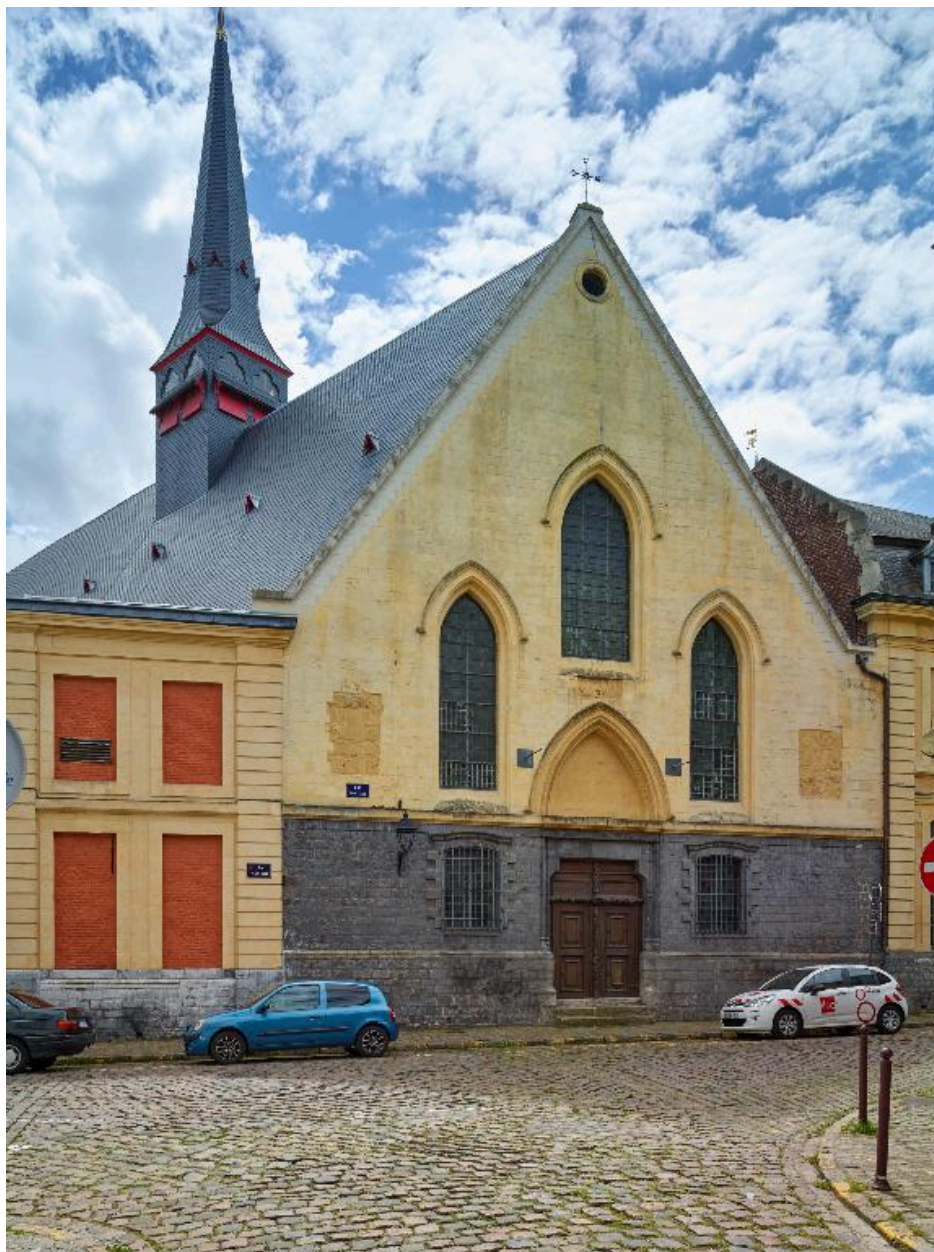
Bâtiment abritant la grande salle des malades, élévation de sa façade donnant sur la rue Comtesse, vue prise de trois quarts gauche.
