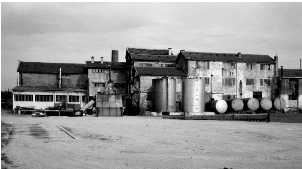
Vue générale : flanc ouest.
