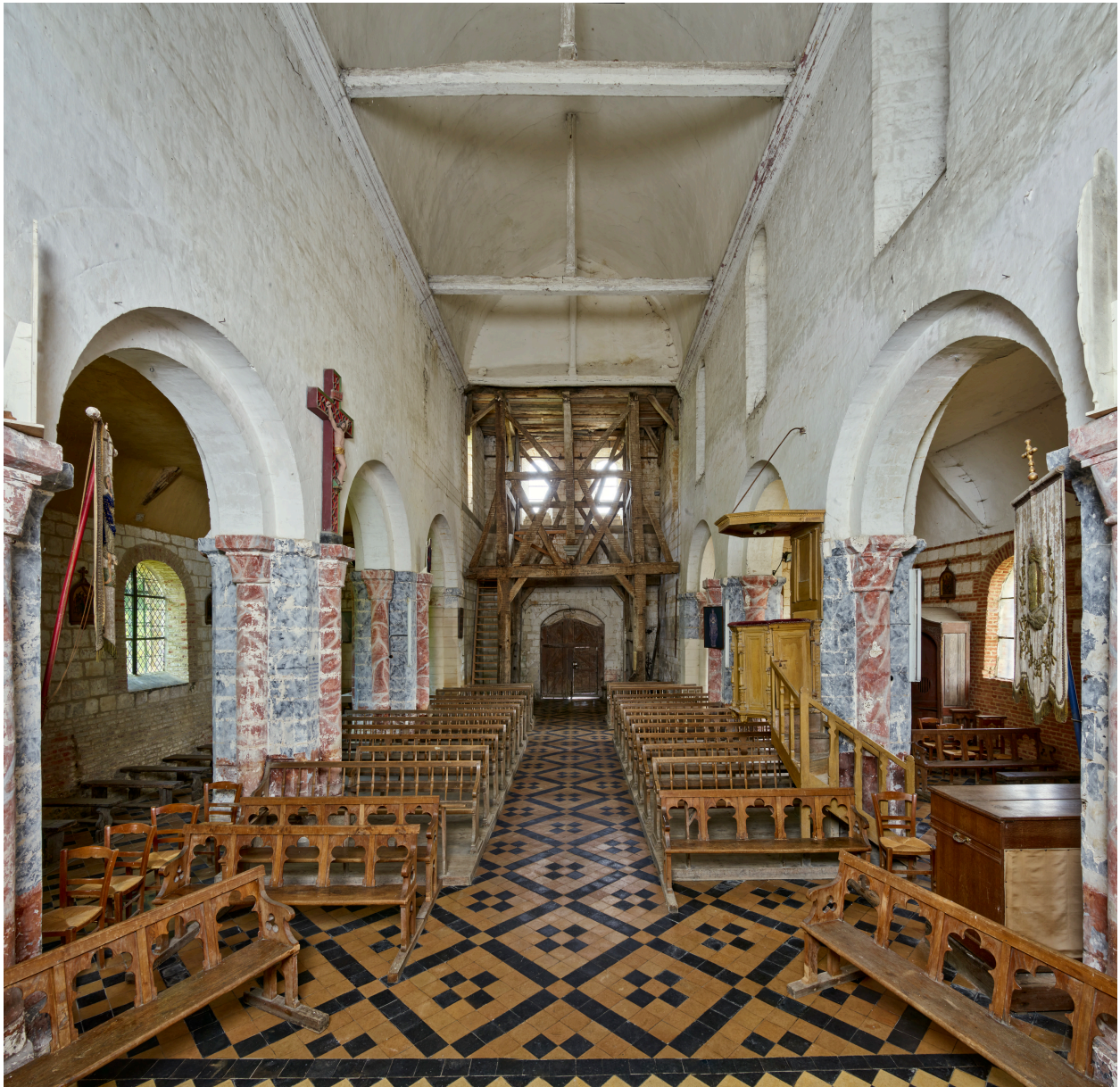
Intérieur, vue de la nef depuis l'ancienne croisée du transept.
