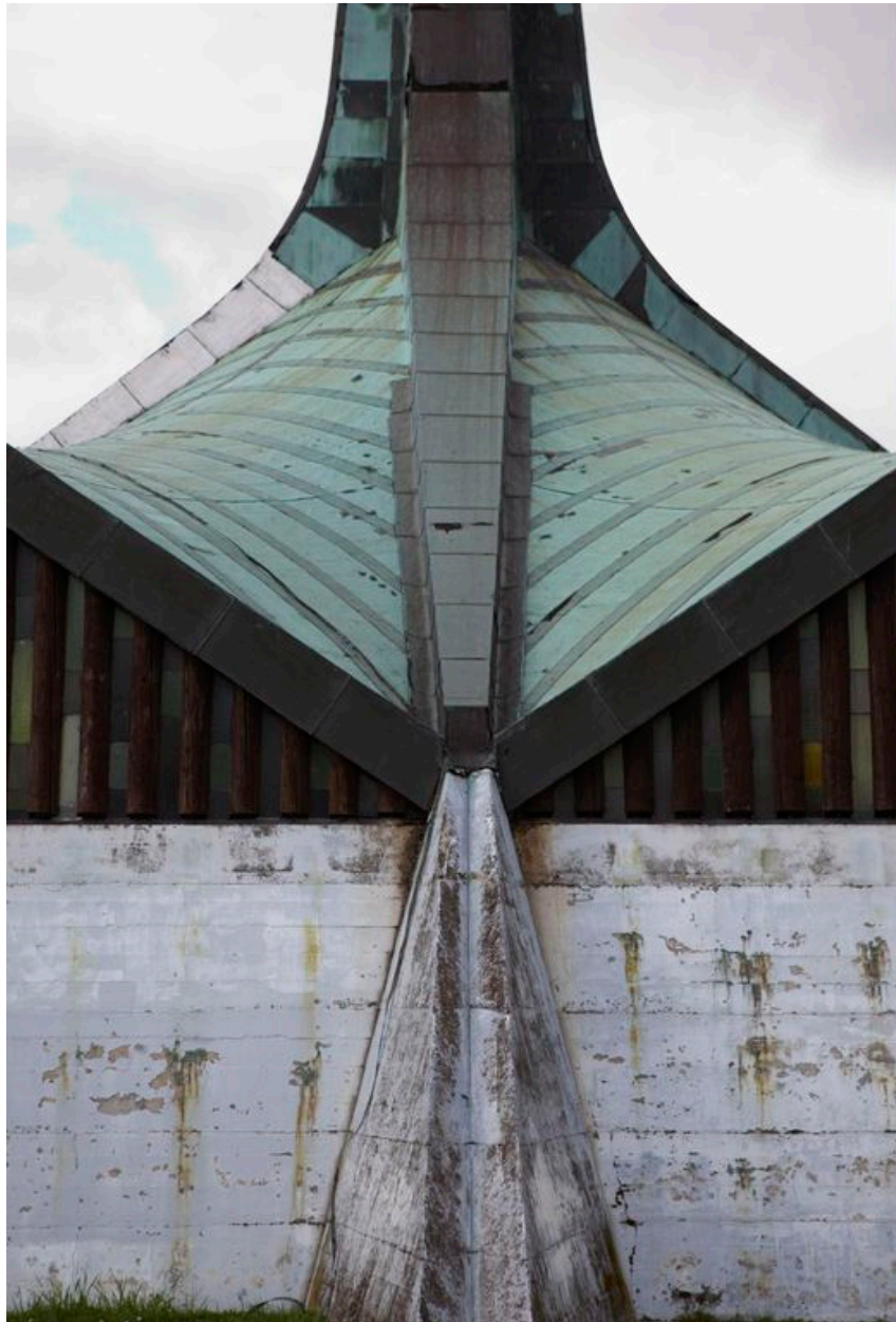
Vue depuis le sud-ouest : contrefort, départ de toit.
