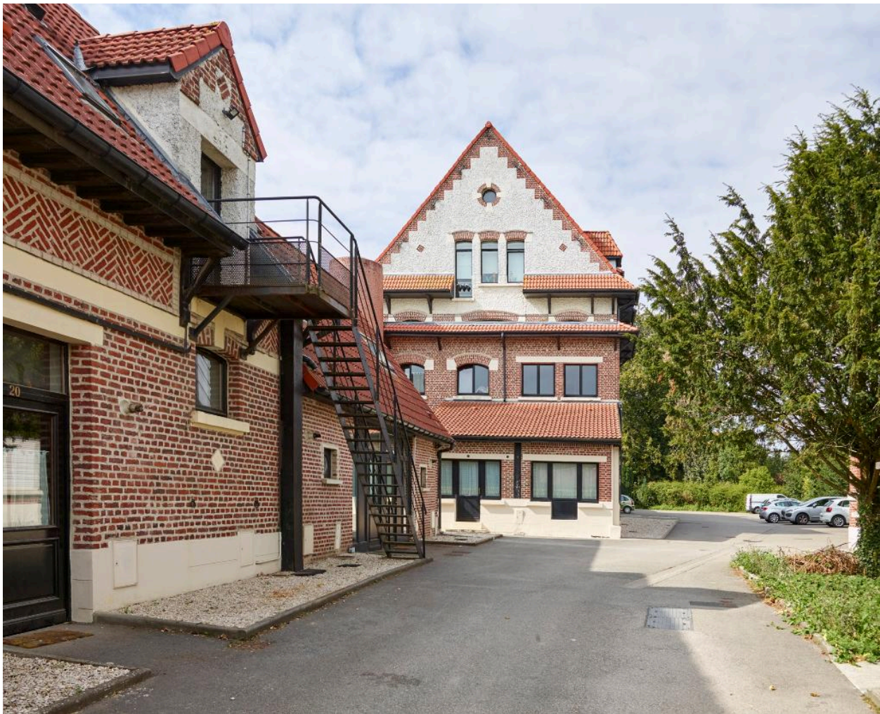
Façade sur cour de l'ancienne écurie et mur pignon de la brasserie vus depuis la rue du Maréchal Leclerc.
