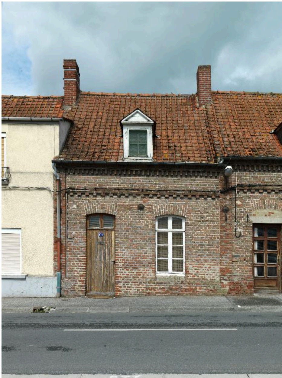
Façade sur rue du logement au 159, rue des Moulins-Bleus.
