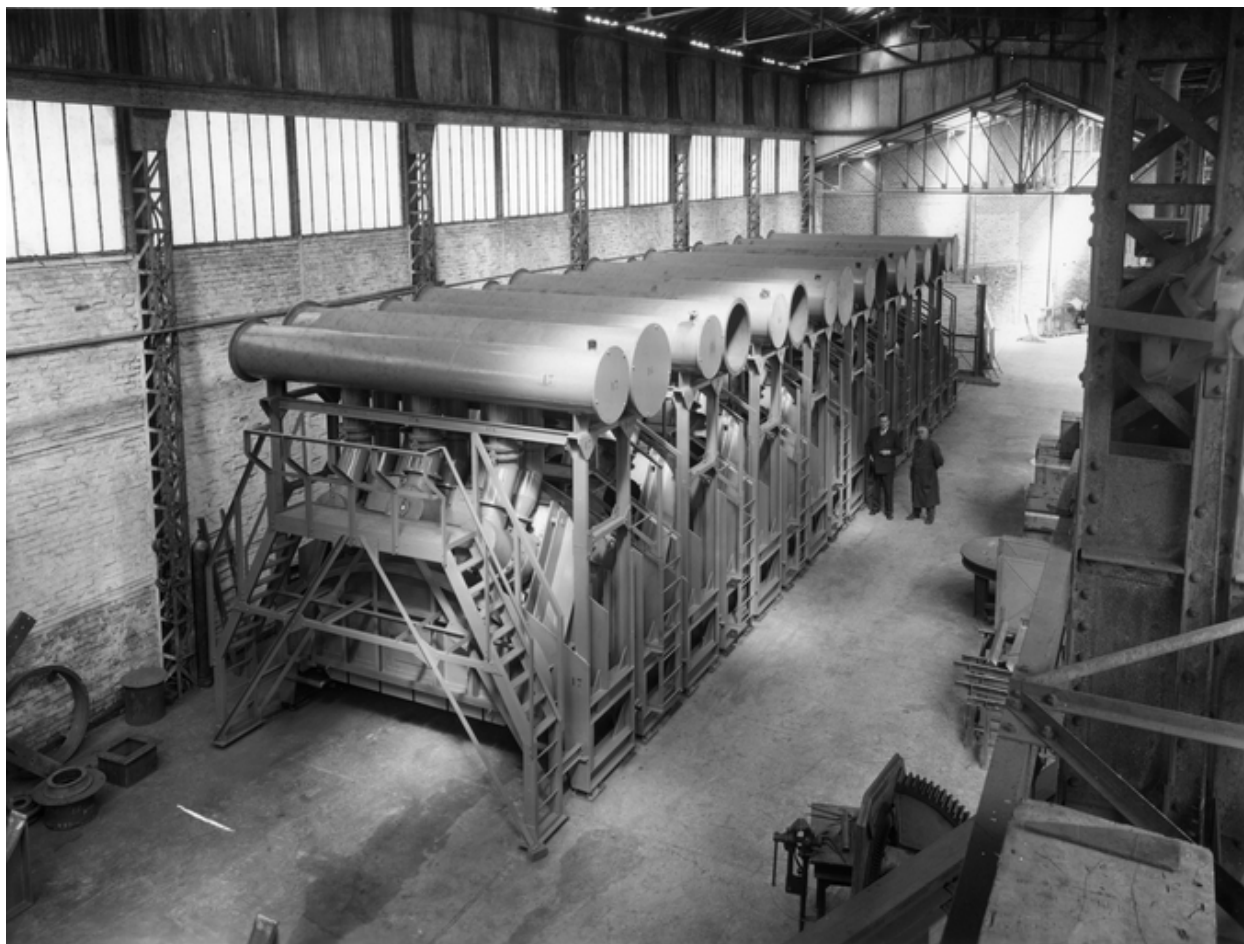
Construction d'un tunnel d'agglomération, vers 1965 (BM Saint-Quentin).
