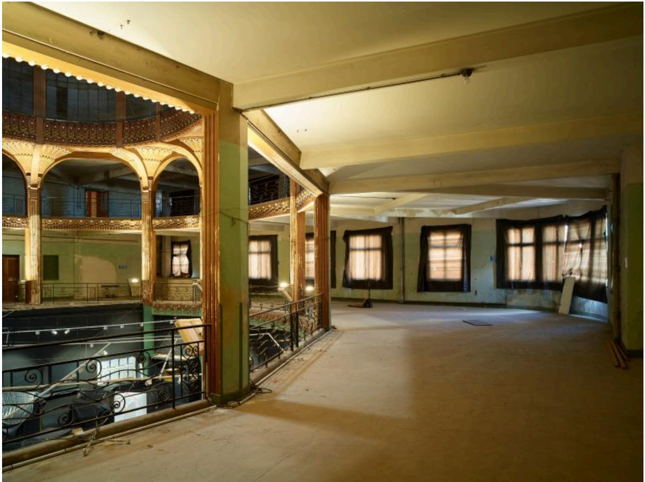
Espace de circulation au premier étage de l'atrium ovale.
