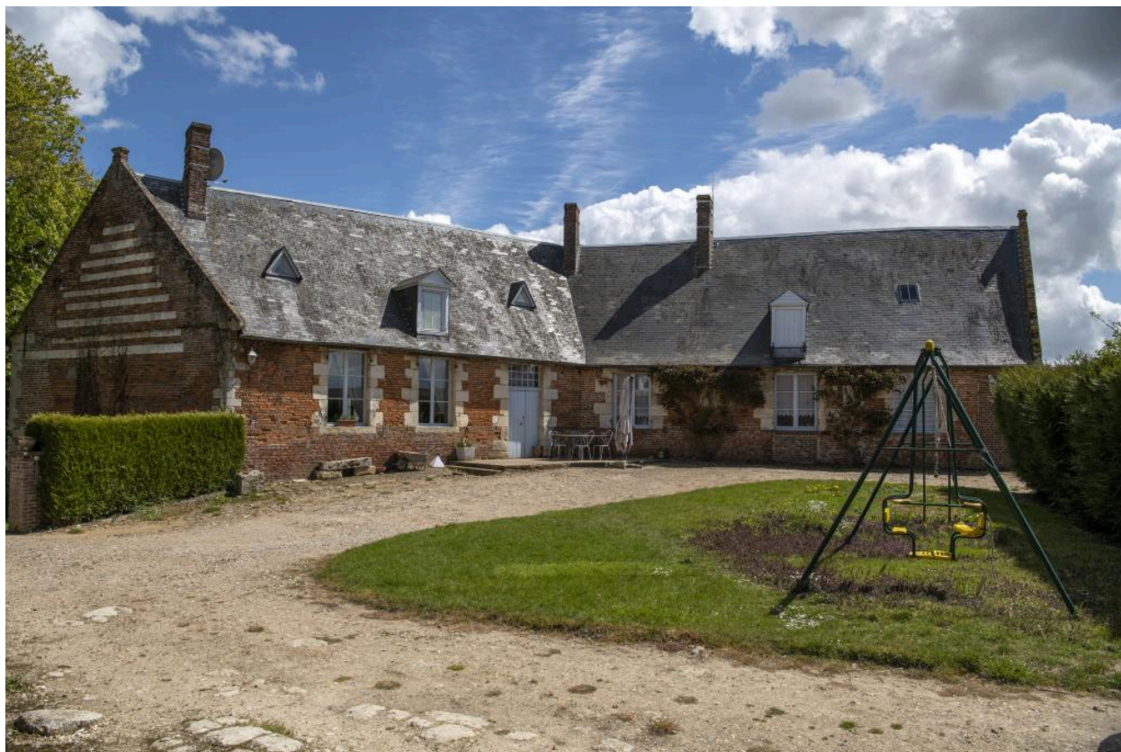
Logis (17e siècle?), vue depuis le nord-ouest.
