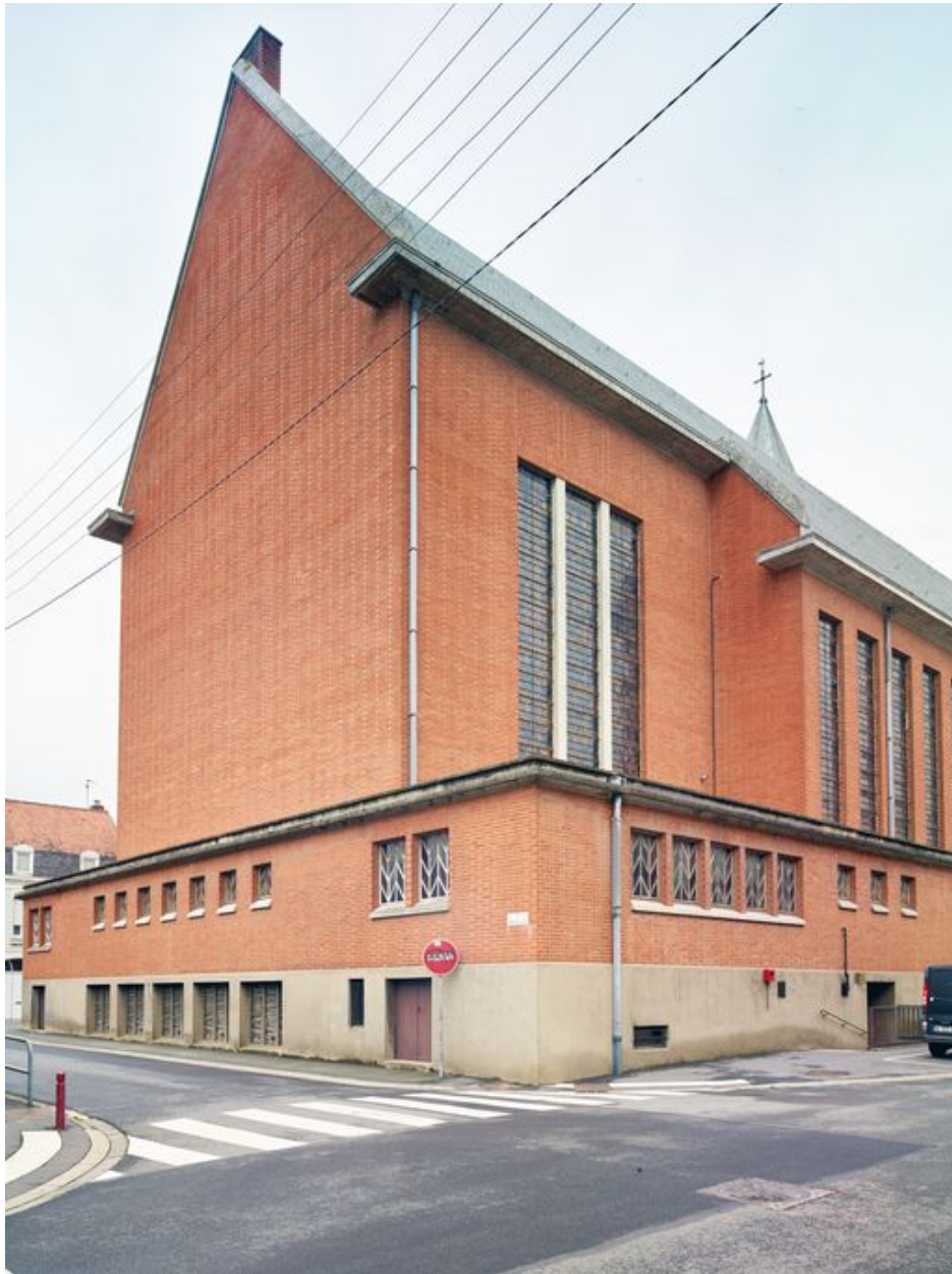
Élévation postérieure de l'église.
