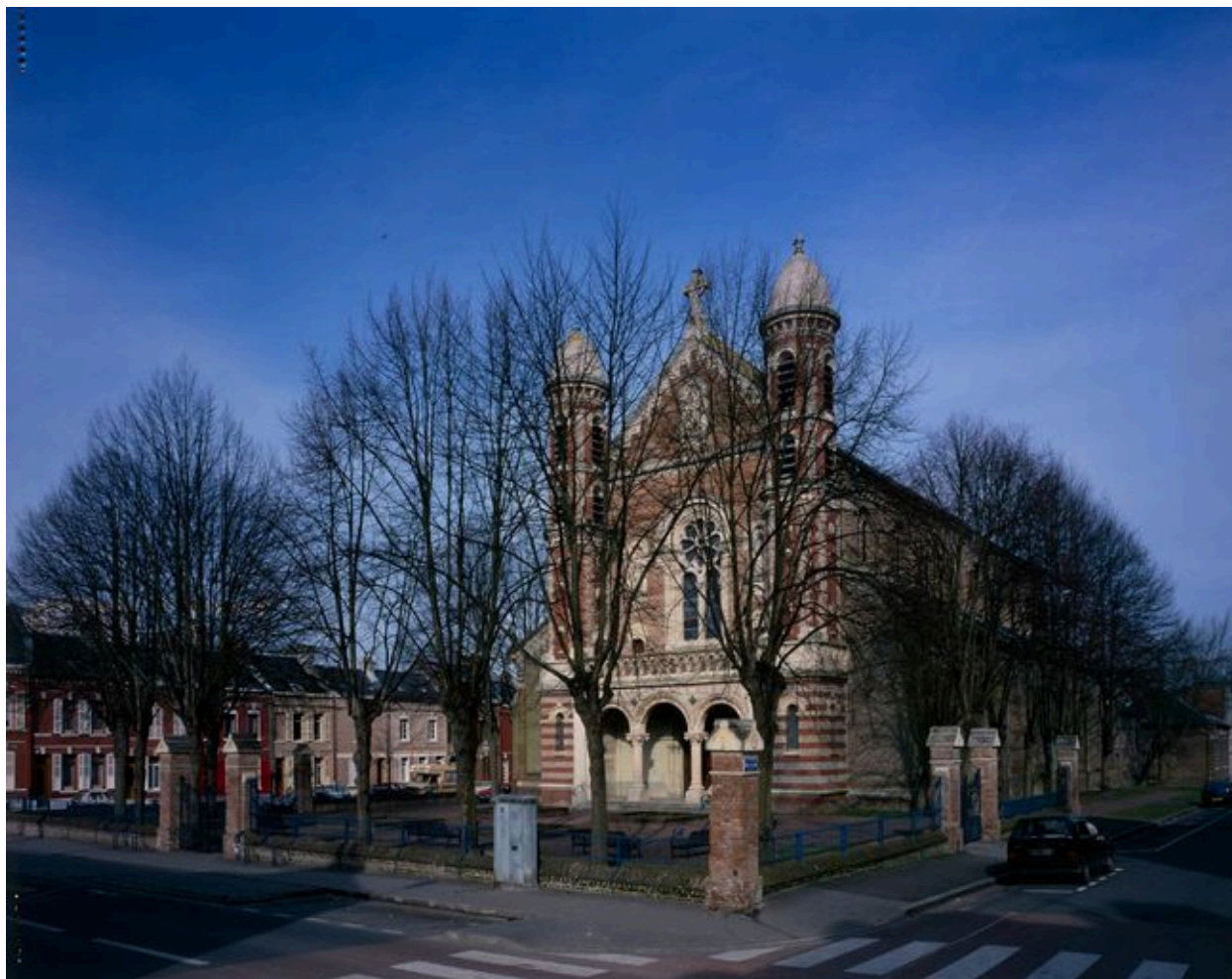
Vue générale depuis l'ouest.
