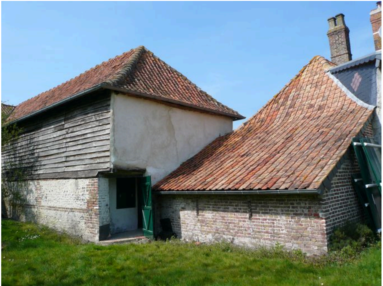
Vue postérieure de la grange et de l'angle sud-ouest du logis, avec passage couvert de la cour vers la pâture.
