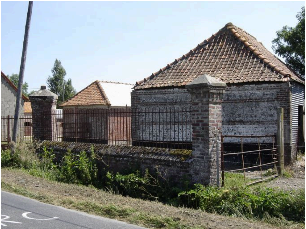
Vue sur l'angle sud-ouest de l'ensemble avant la destruction des bâtiments.
