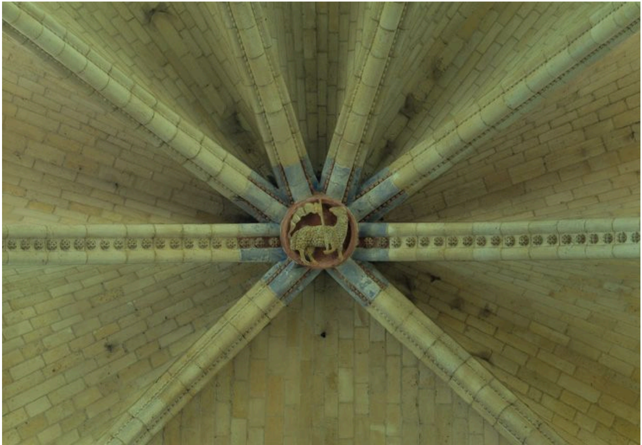
Vue intérieure des tribunes du choeur, clef de voûte avec l'Agnus Dei.
