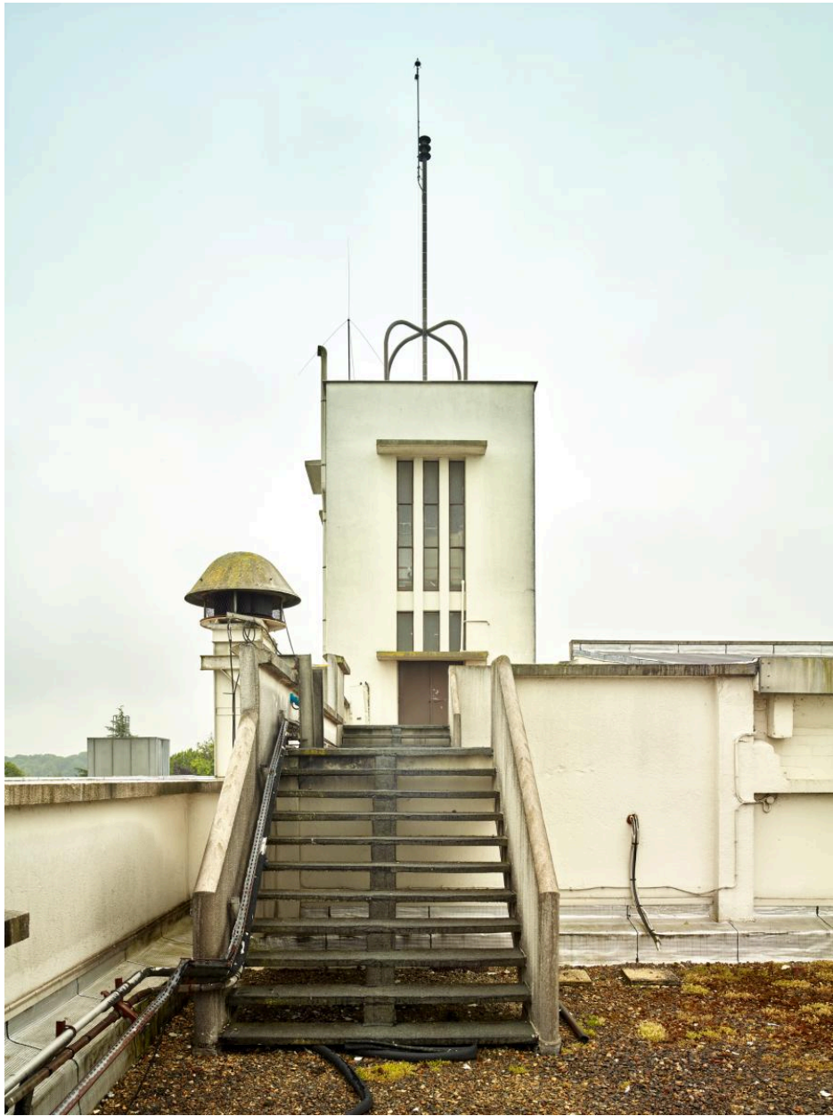
Tour surmontant l'atelier de fabrication (H) depuis le couverture du bâtiment de conditionnement (AH), vers le sud.
