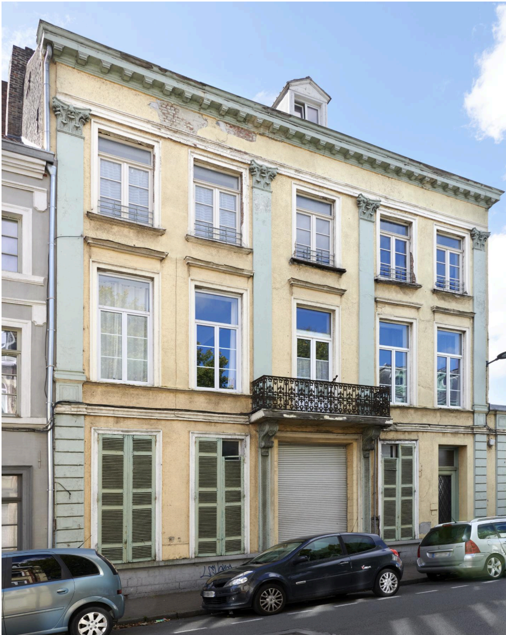
Vue générale de la façade.
