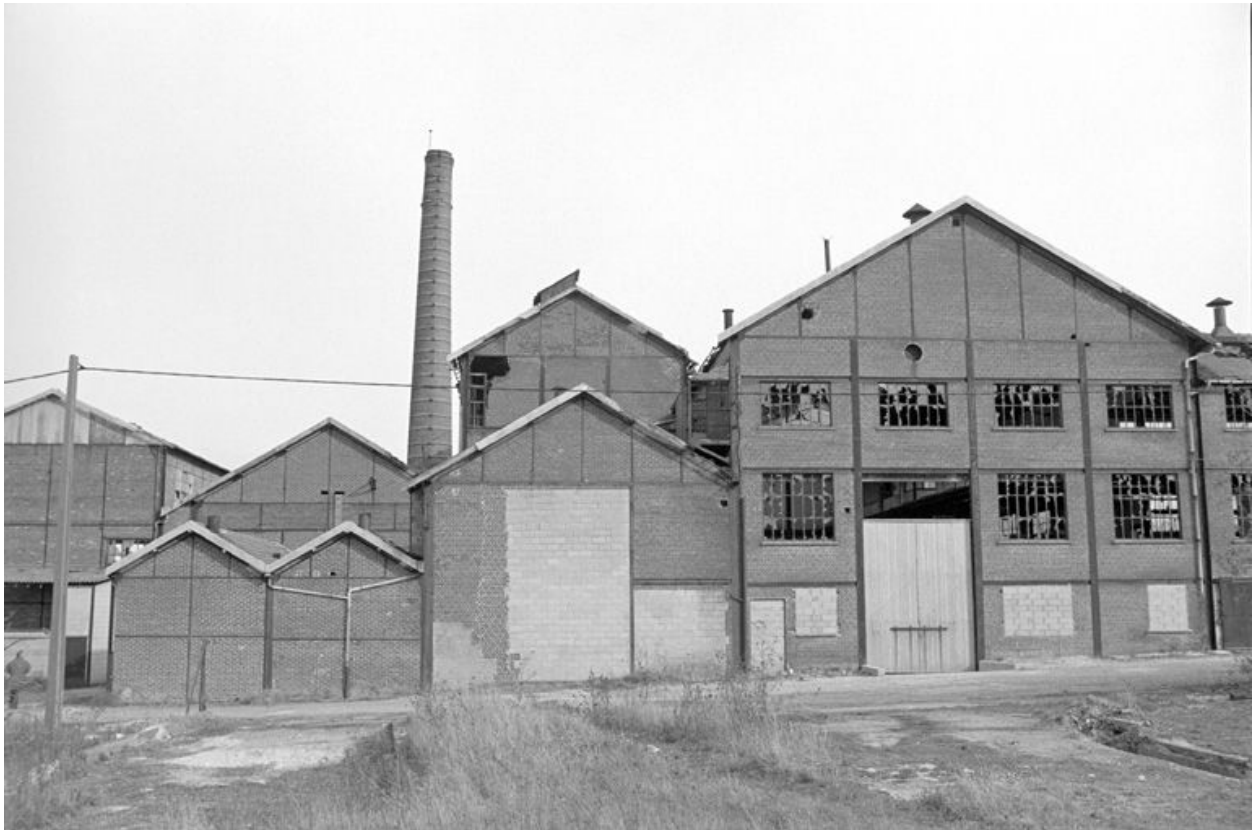
Atelier de fabrication, flanc ouest.
