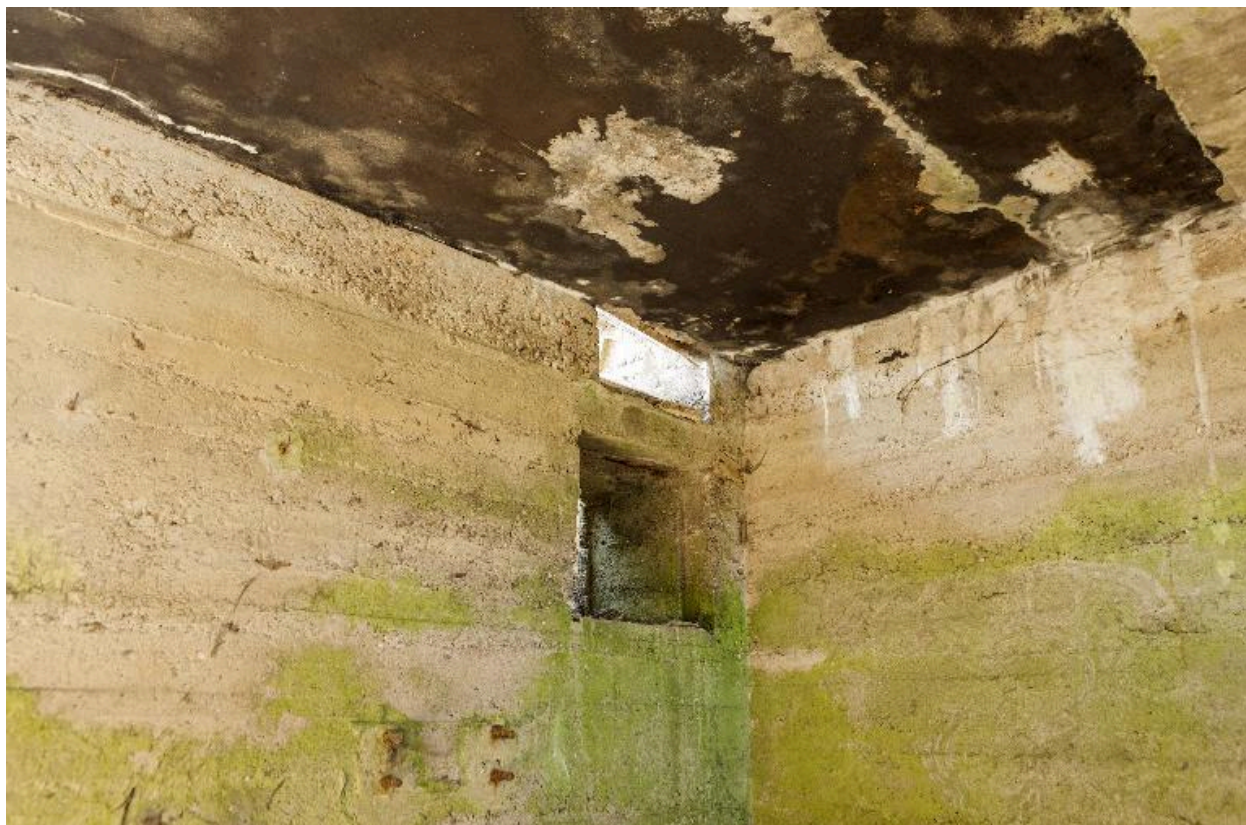
Bâtiment 2, vue intérieure
