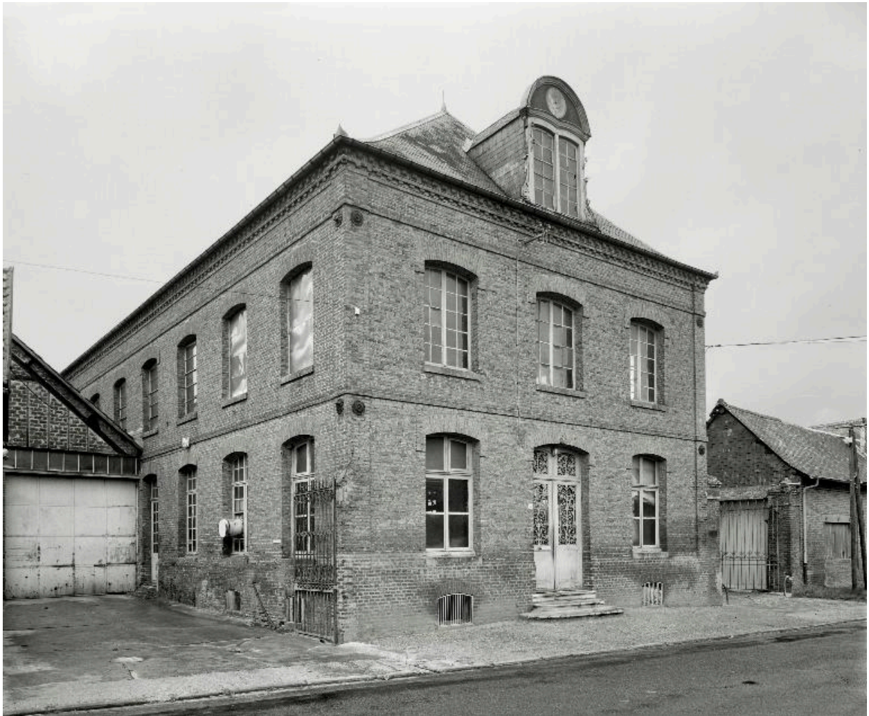
Elévation antérieur de l'usine et vue de l'atelier de fabrication, en 1990.
