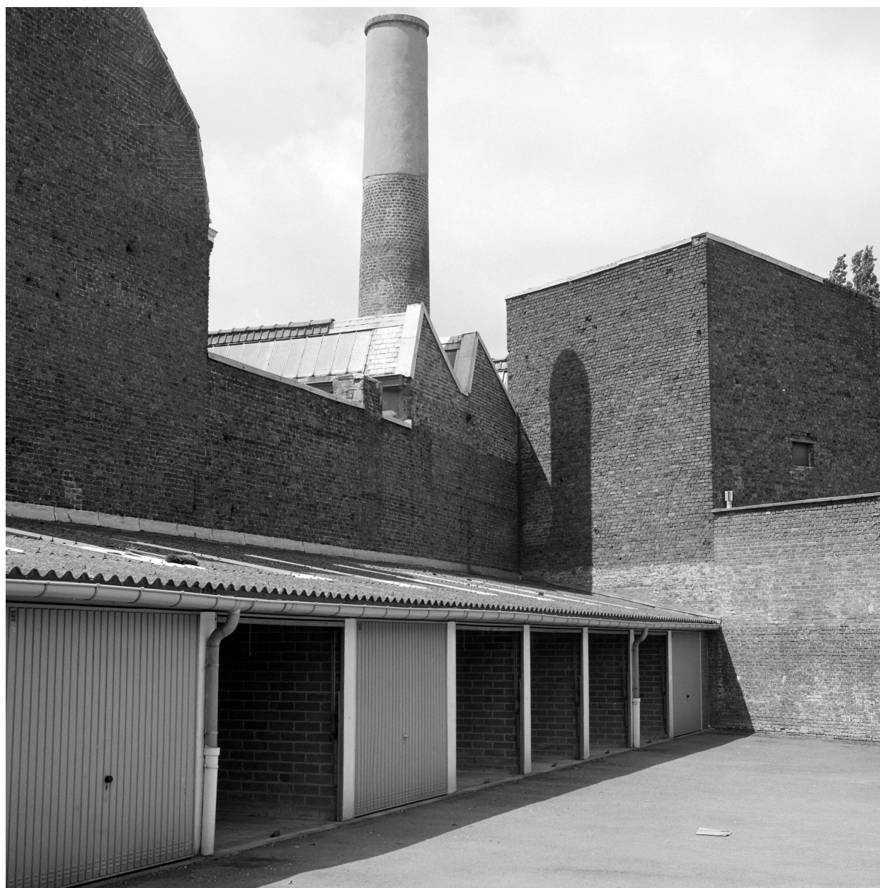
Élévation postérieure, atelier de fabrication.
