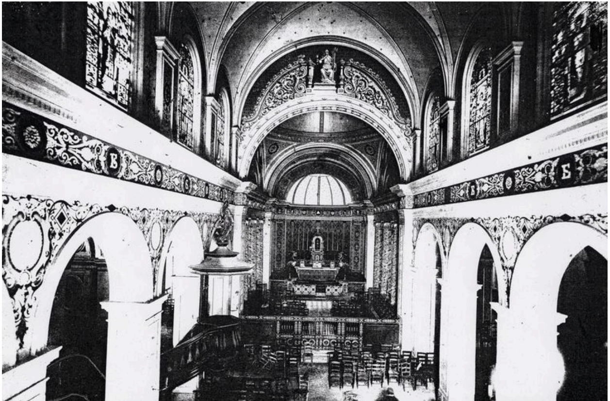
Vue intérieure de l'ancienne église Sainte-Anne, vers 1859 (AP Congrégation).
