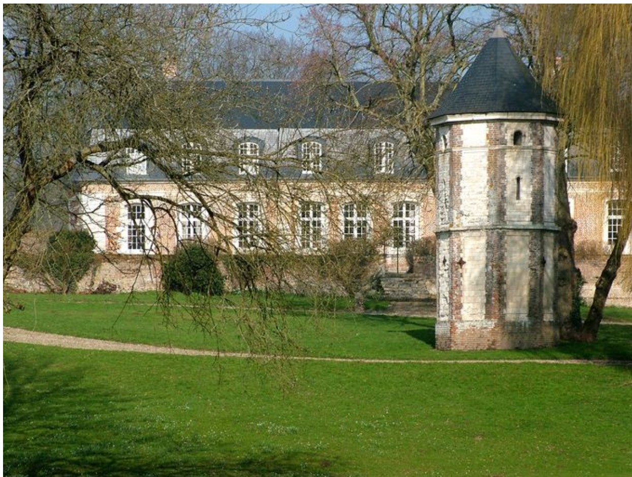
Vue du colombier et du logis depuis l'étang.
