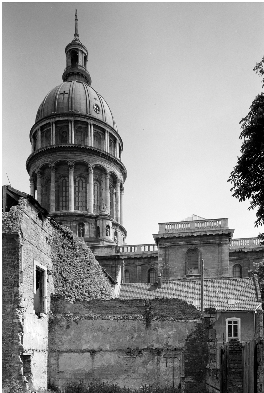
Bâtiment G, conciergerie, vue d'angle.
