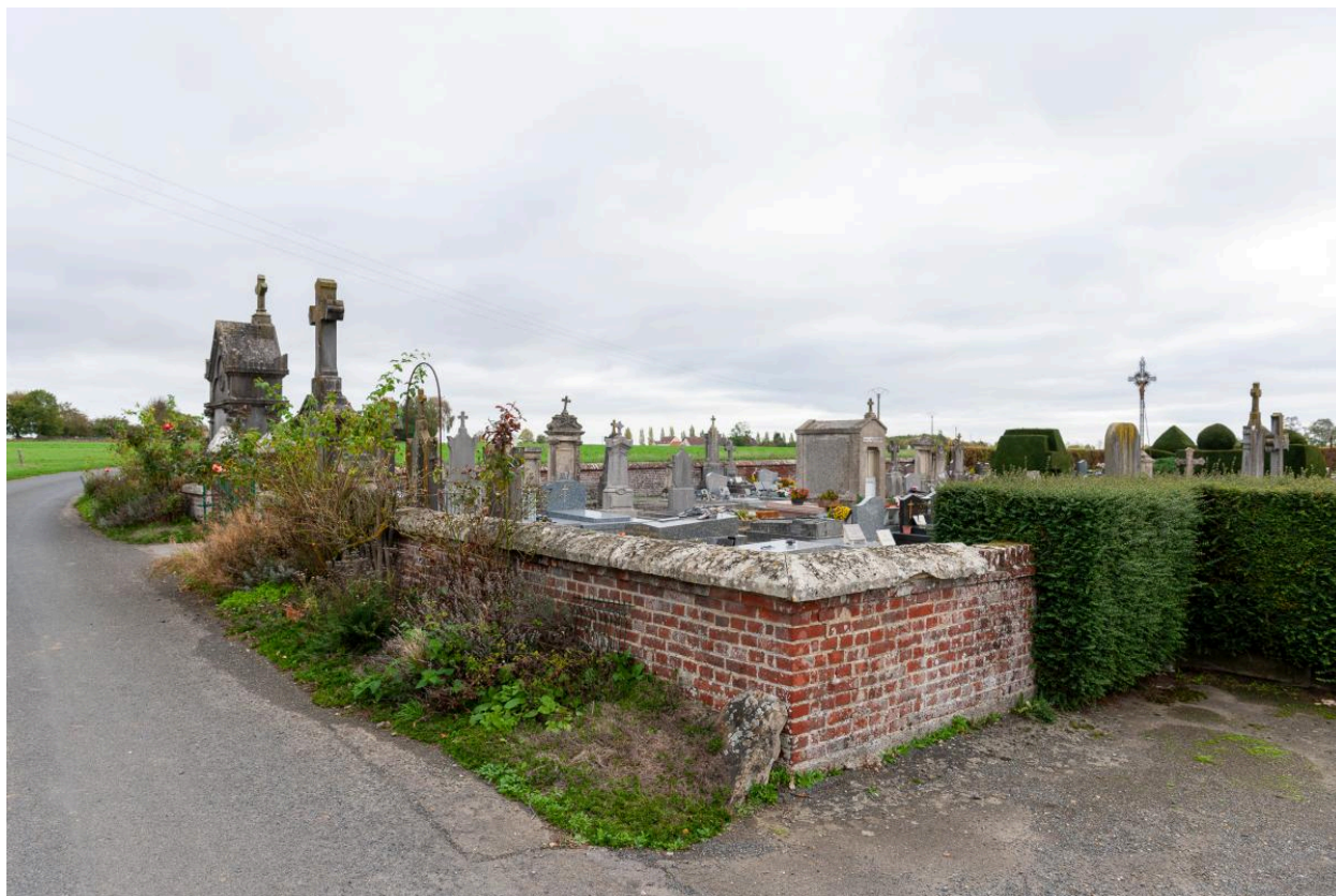
Vue générale depuis l'est.
