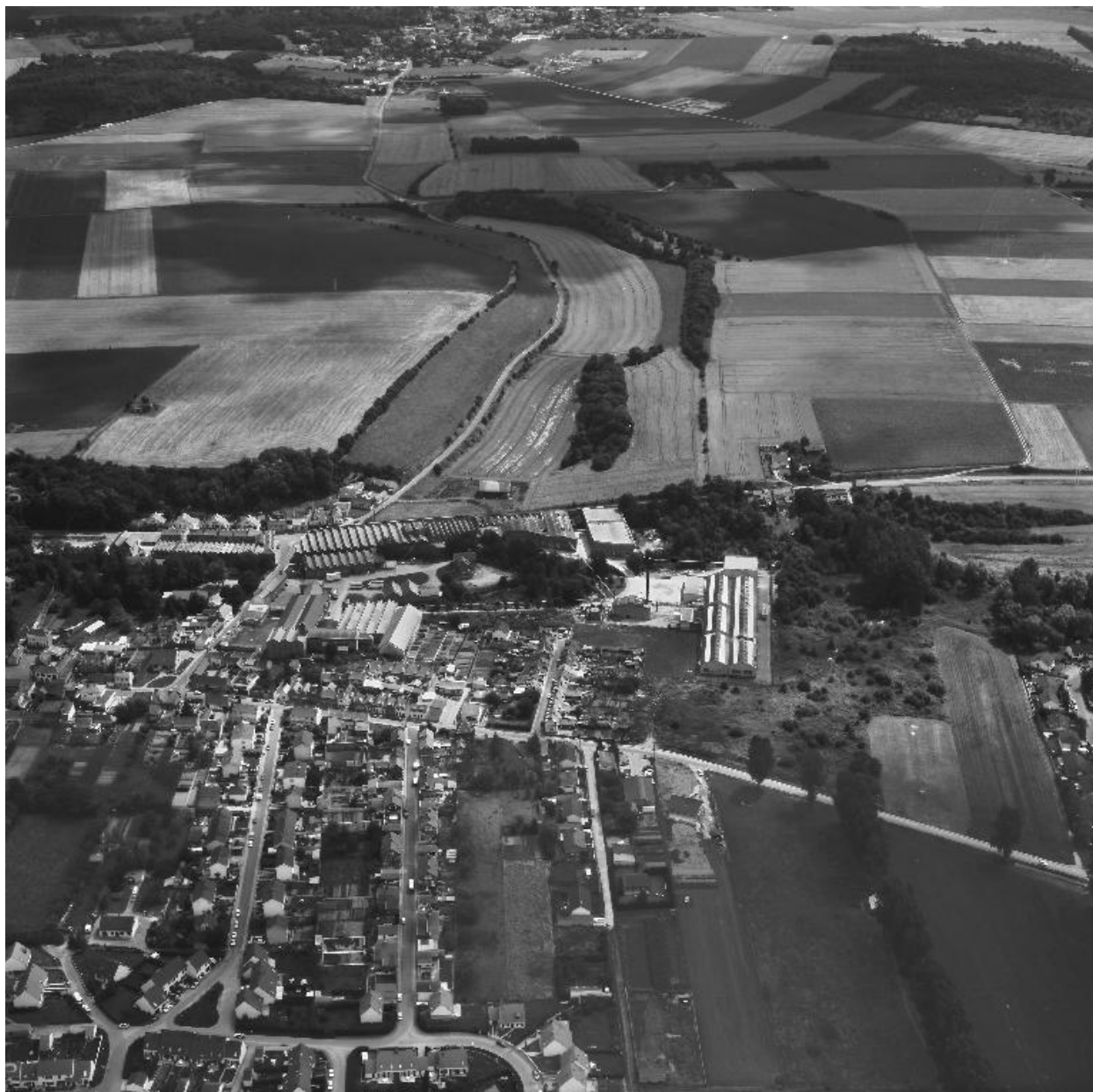
Vue aérienne, flanc ouest.
