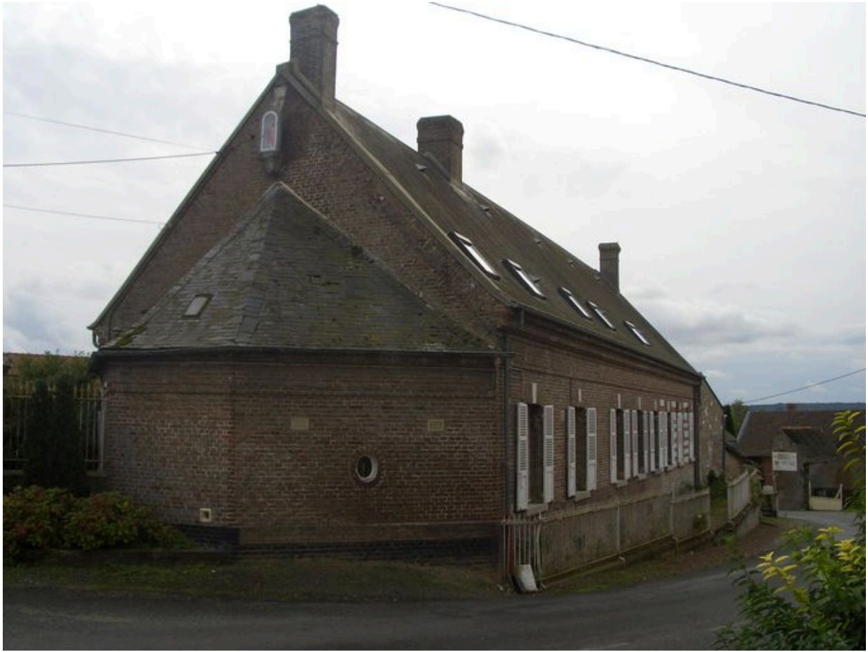
Vue latérale du logis avec appentis au nord.
