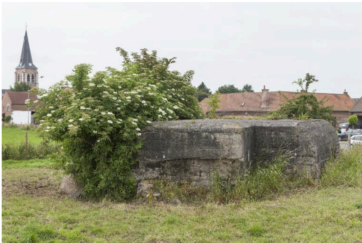
Casemate a, vers le sud-ouest
