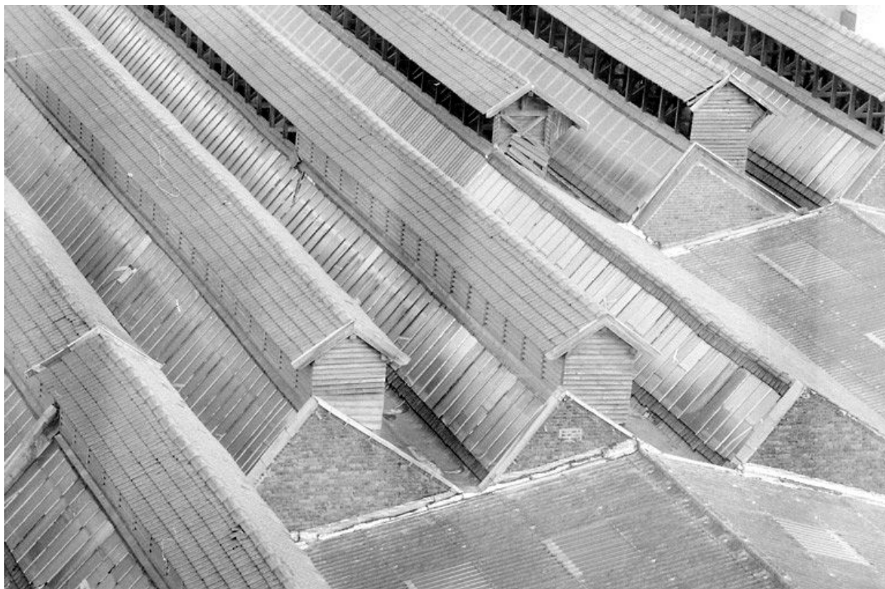
Atelier de fabrication, détail des sheds.
