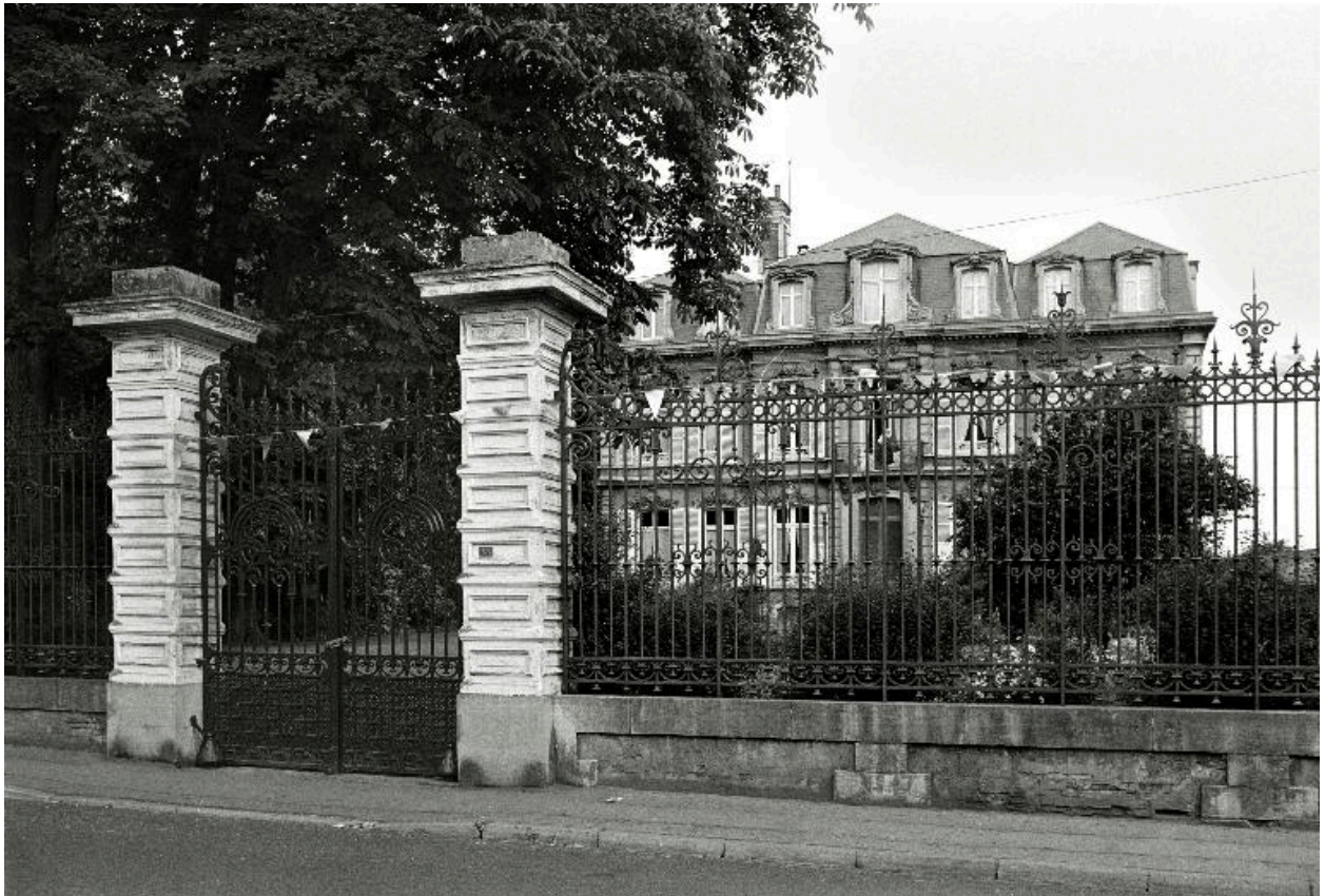
Le portail et la grille de clôture, en 1990.
