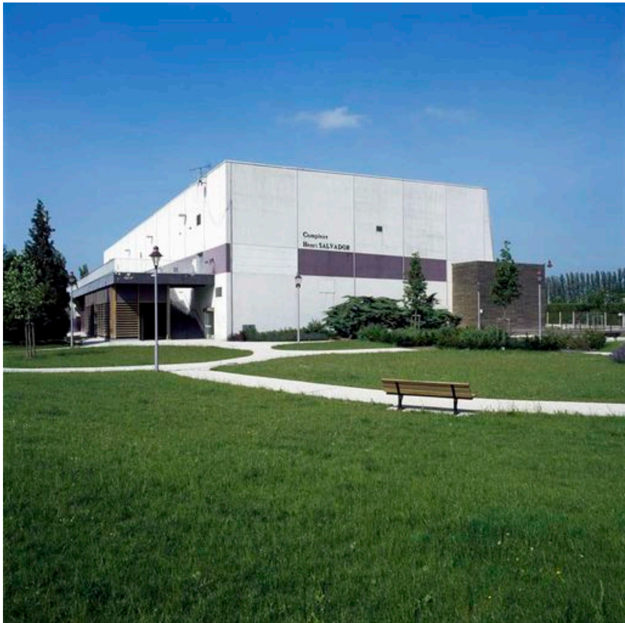
Façades sud-est du complexe sportif.
