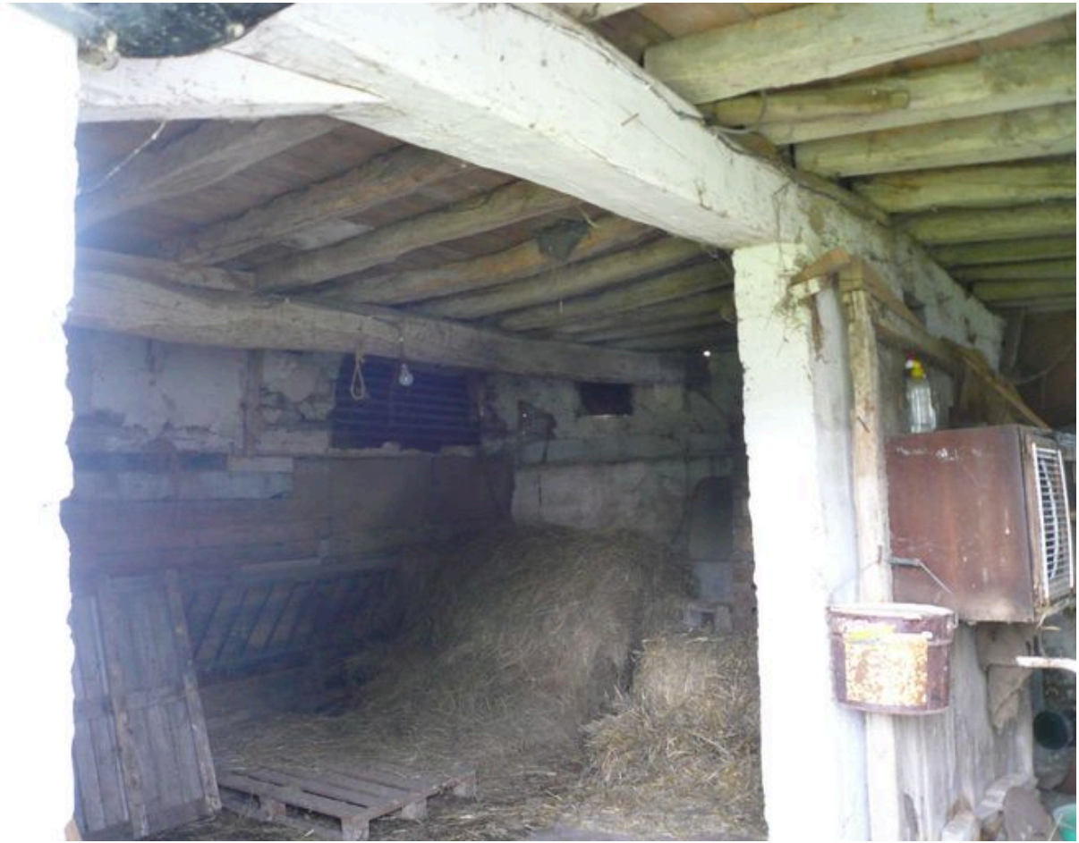
Vue intérieure de la partie étable.
