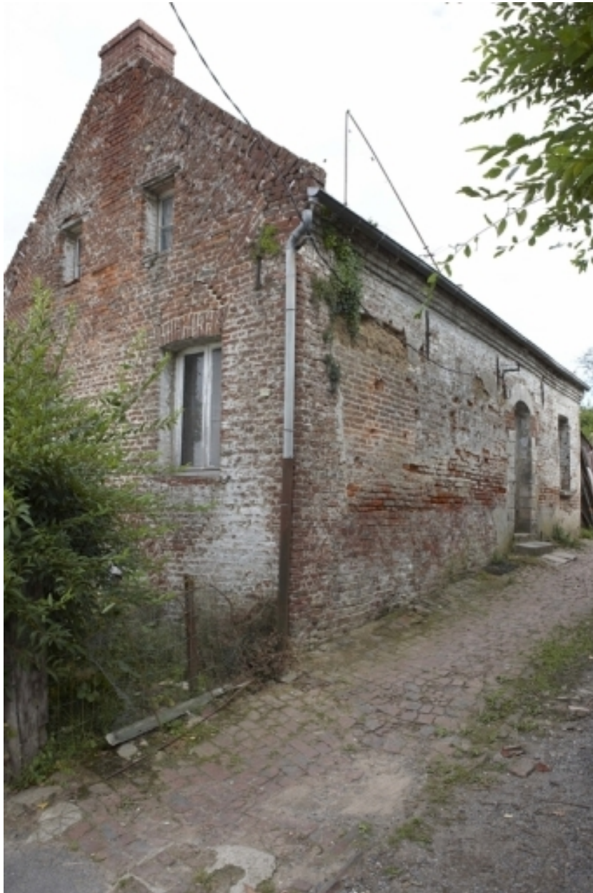
Vue du pignon sur rue et de l'élévation sud.
