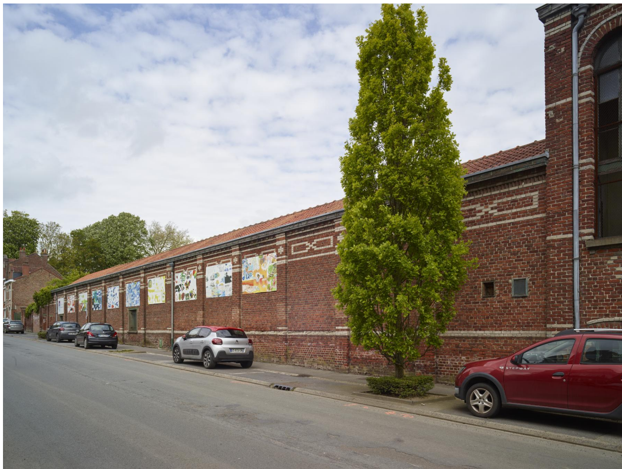
Vue générale depuis la rue Émile-Hié, vers le nord. Façade ouest du laboratoire.
