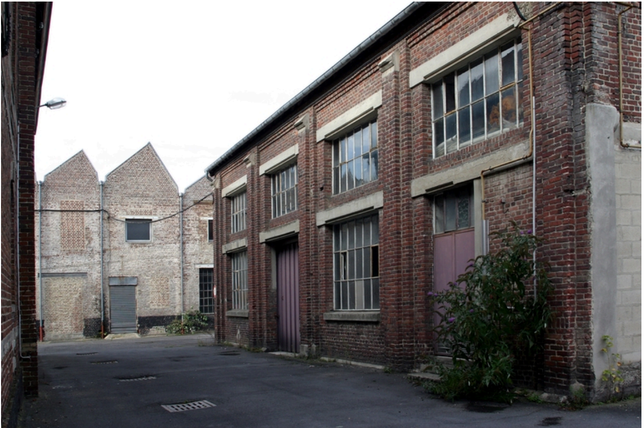
Pignon sud de l'un des deux grands ateliers de guipure reconstruits en 1919.
