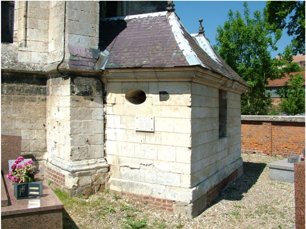
Sacristie jouxtant le pan sud-ouest de l'abside.
