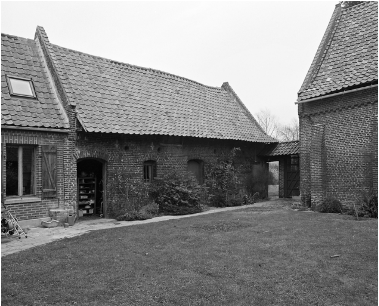
Elévation antérieure de l'étable-écurie sur cour.
