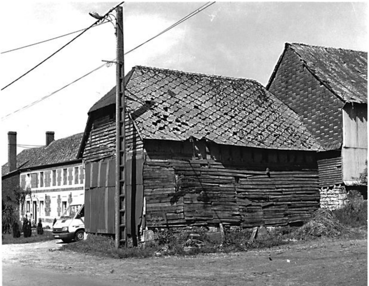
Ancien logis, depuis le sud-ouest (transformé en grange)
