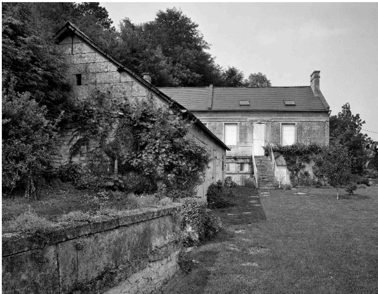
Maison, 4 rue de l'Église : vue d'ensemble depuis le sud.
