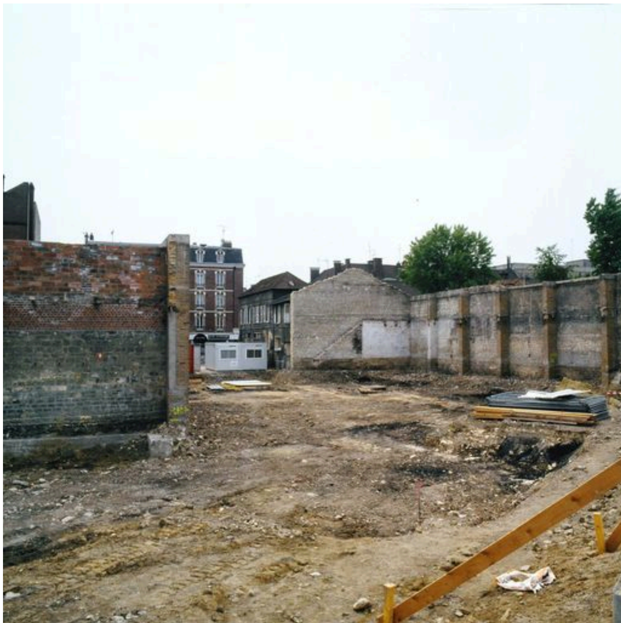
Démolition des bâtiments en 2007.
